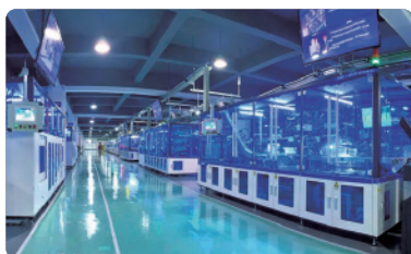
Fábrica inteligente de baja tensión de Wenzhou China
